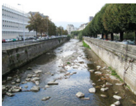
La Leysse à Chambéry en 2005 et en 2023. Le lit de la Leysse a fait l'objet en 2006 d'un programme de travaux pour augmenter son gabarit (par approfondissement) et le revégétaliser. Des petites terrasses basses alluviales ont ainsi été restaurées pour permettre le développement des saulaies arbustives. Leur présence est parfaitement compatible avec le bon écoulement des crues et a permis de restaurer une certaine biodiversité. (©Boyer M./Aquabio)
