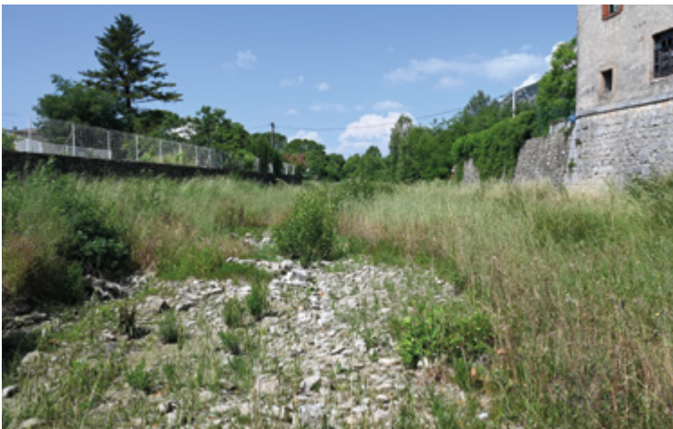
Exemple de cours d'eau canalisé sur son cône de déjection. Le moindre débordement peut impacter de nombreuses habitations situées en contrebas. Le lit doit donc être débroussaillé tous les ans pour réduire les hauteurs d'eau en crue. (©Boyer M./Aquabio)
