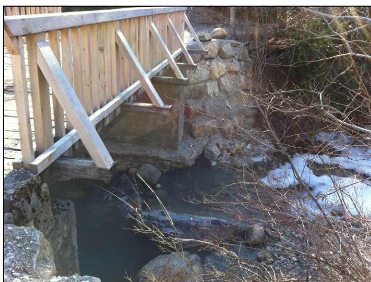
Passerelle neuve et enrochement bétonné sur Chaudanne
