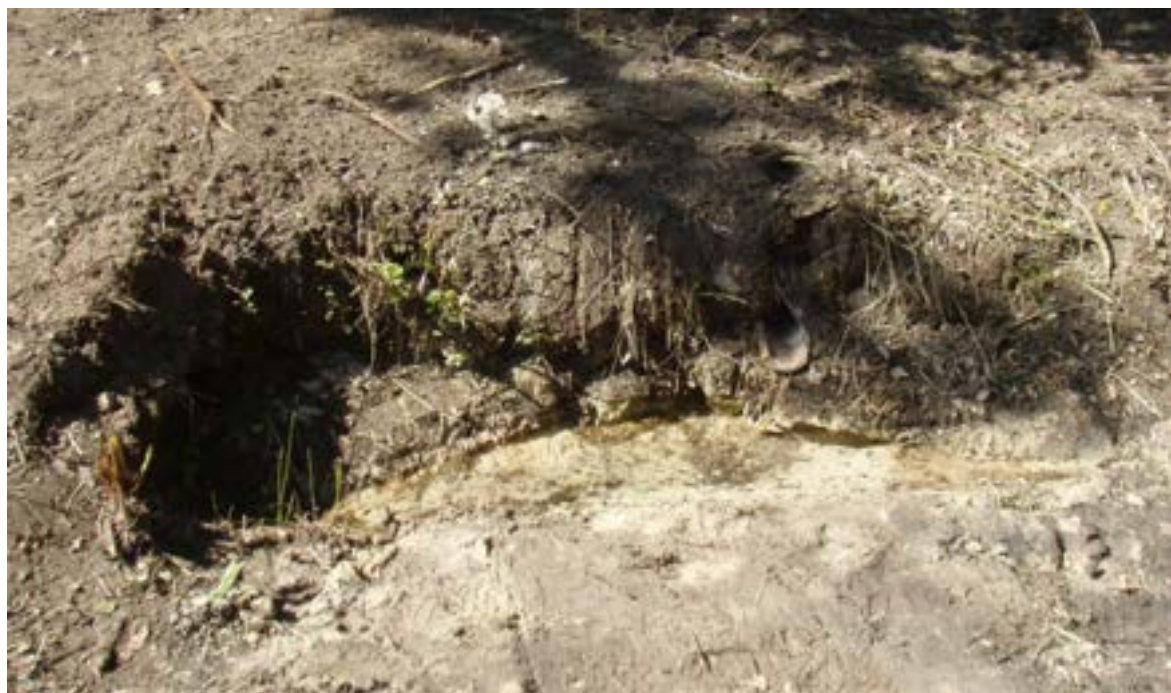
LA PARTIE AMONT DU DRAIN DECAISSE EN 2011 DECOUVRE D'ANCIENNES CANALISATIONS EN TERRE CUITE (MANCHONS DE TUILEAUX) (PHOTO MRE)
