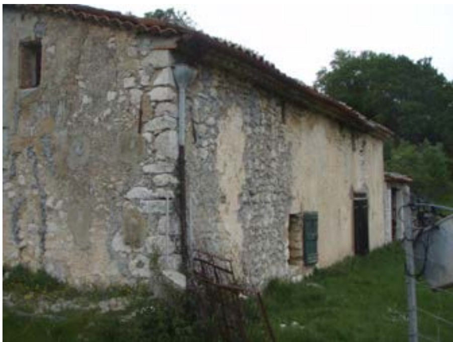
BERGERIE AVEC SA TOITURE EN UN SEUL PAN ET SON SYSTEME DE GOUTTIERE (PHOTO MRE)
