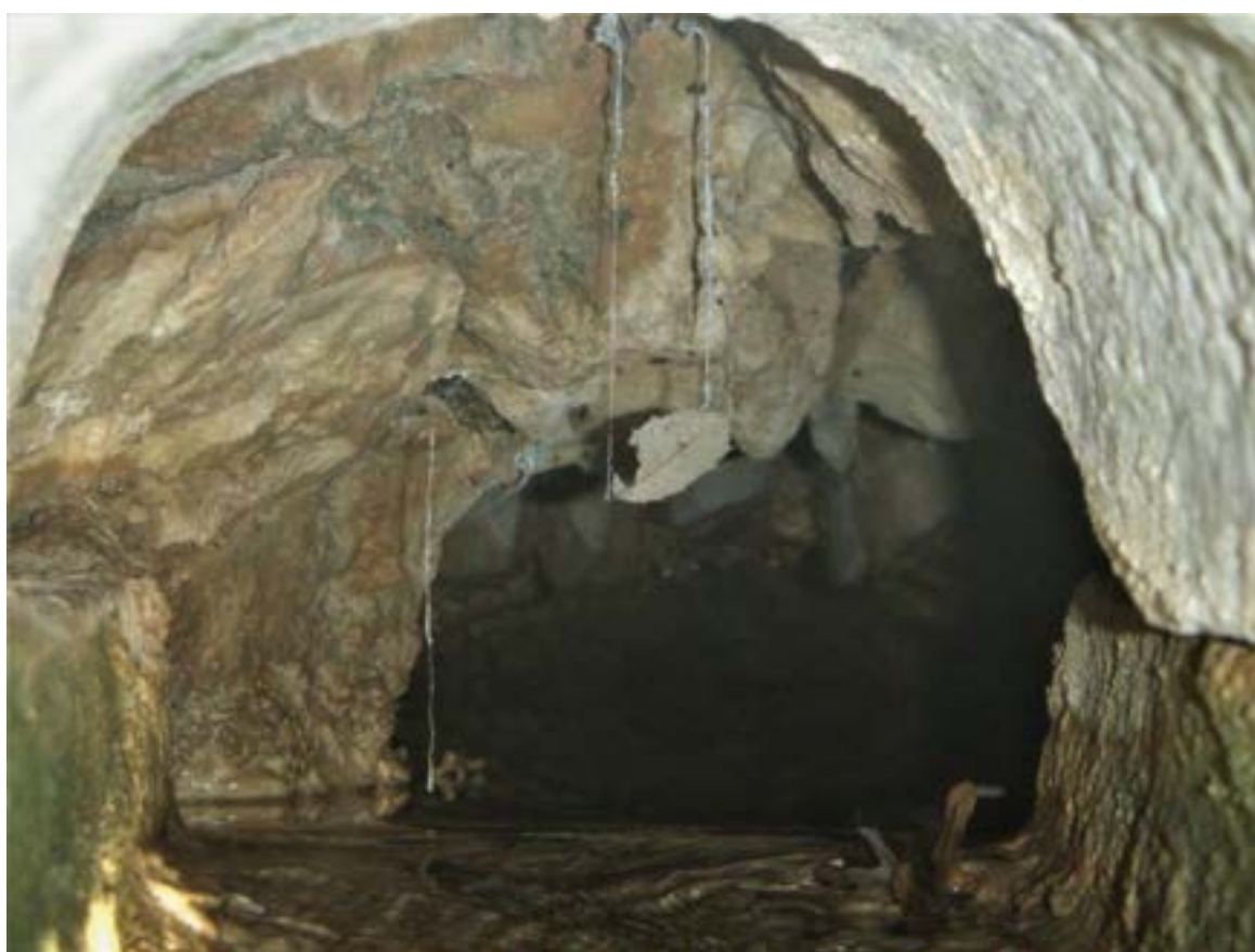
L'EAU DRAINEE SUIV LA PENTE DANS UNE CONSTRUCTION DE PIERRES SECHES ENSEVELIES (PHOTO MRE)
