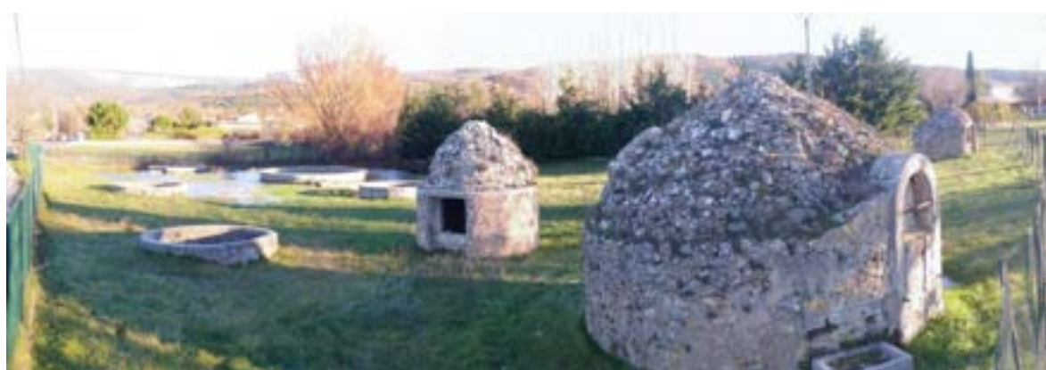
DISPOSITION DES NEUF « Puits-citerne » DANS LE CHAMPS CAPTANT, AU POINT BAS DE LA CUVETTE TOPOGRAPHIQUE, EN PERIODE DE « HAUTES EAUX » (PHOTO MRE)
