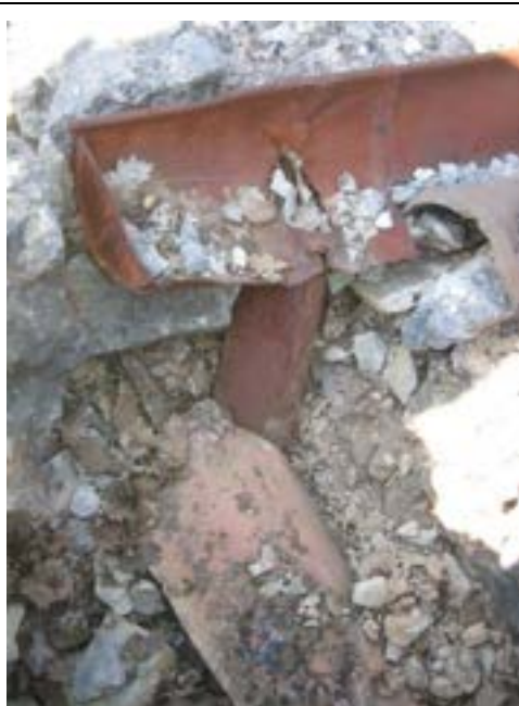
DETAIL D'UNE DES DEUX GOUTTIERES (PHOTO DE GAUCHE) ET DE SA PARTIE RACCORDEE A LA CITERNE (PHOTO DE DROITE) (PHOTOS MRE)
