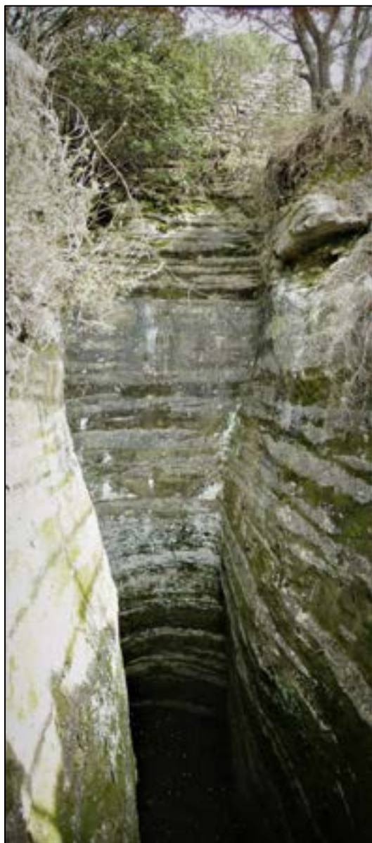
DETAILS DE LA CITERNE CREUSEE DANS LA ROCHE MERE EN CONTREBAS D'UNE LONGUE MURAILLE (PHOTO MRE)
