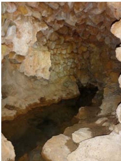
CHAMBRE DE CAPTAGE DE LA MINE AMENAGEE DANS UNE PETITE CAVITE NATURELLE DE LA ROCHE (PHOTOS MRE)
