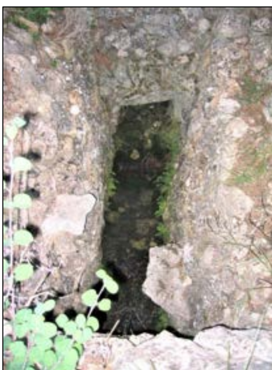
REGARD D'ACCES AU DEBOUCHE DU DRAIN AU POINT PAS DE LA MURAILLE LA PLUS EN AVAL DU COMPLEXE (PHOTO MRE)
