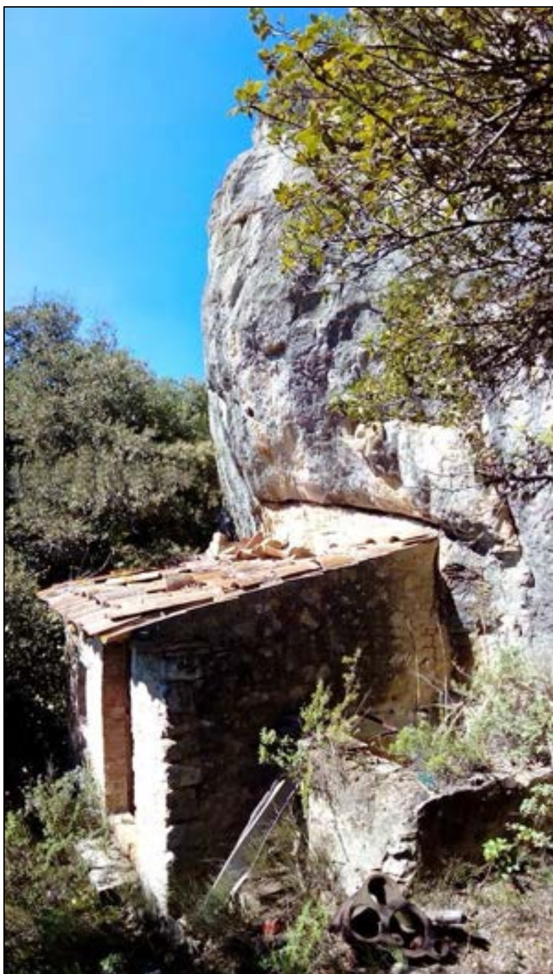
VUE D'ENSEMBLE DU CABANON ADOSSE A LA PAROI ROCHEUSE. UNE « GOUTTE » TAILLEE DANS LA PAROI ET UNE TOITURE EQUIPEE D'UNE GOUTTIERE PERMETTAIENT D'ALIMENTER UNE CITERNE BATIE (AU PREMIER PLAN A DROITE) (PHOTO MRE)
