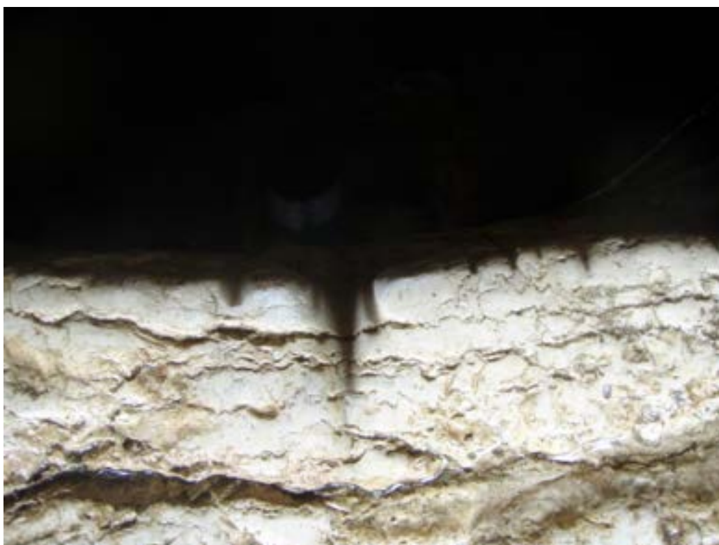
LES MARQUES D'USURES SUR LA TRANCHE DE LA PIERRE DE MARGELLE INDIQUENT L'USAGE DE CORDES TRACTÉES, PROBABLEMENT PAR UN ANIMAL (SOUVENT ÉQUIDES) (PHOTO MRE)
