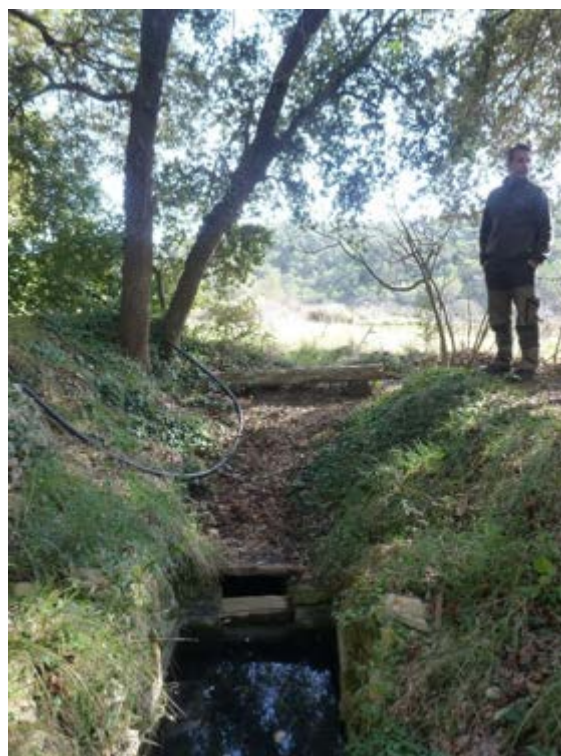
DEBOUCHE DE LA GALERIE (PHOTO DE GAUCHE) ET BASSIN TAMPON POUR LA MISE EN CHARGE DU CANAL (PHOTO DE DROITE) (PHOTO MRE)
