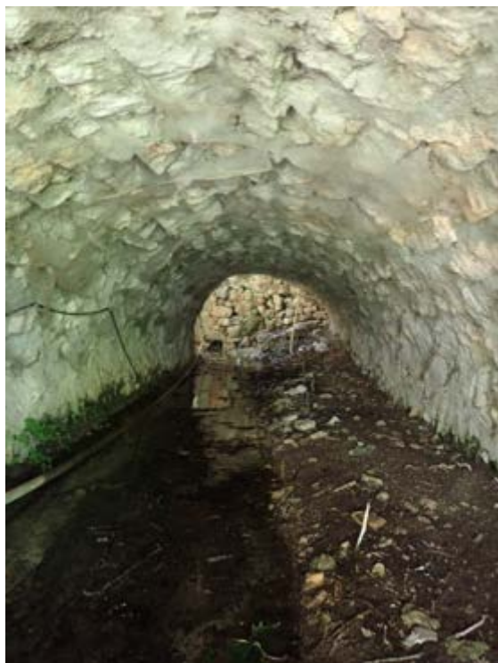
CANAL SOUTERRAIN D'AMENEE D'EAU DU PREMIER AU SECOND BASSIN (PHOTO MRE)
