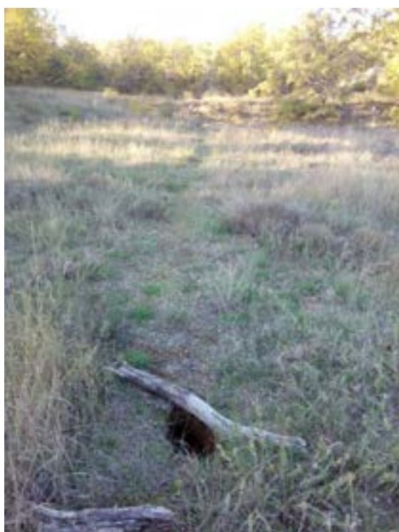
EFFONDREMENT DE LA VOUTE PEU PROFONDE DU DRAIN (PHOTO DE GAUCHE) ET DEBOUCHE DU DRAIN AU PIED DE LA MURAILLE LA PLUS EN AVAL (PHOTO MRE)
