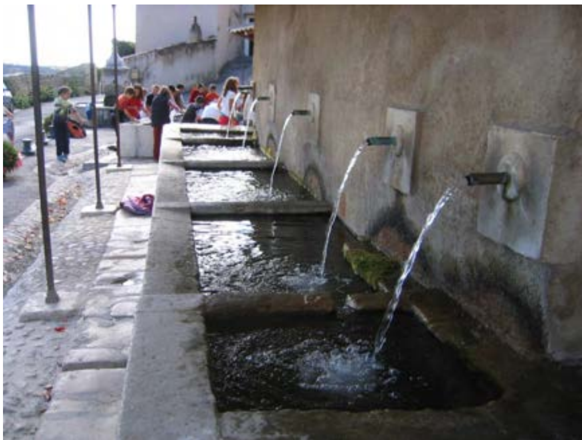
L'EAU SE REPARTIE PAR « DEBORDEMENT » AFIN D'ALIMENTER SIMULTANEMENT FONTAINES ET LAVOIR (PHOTO MRE)
