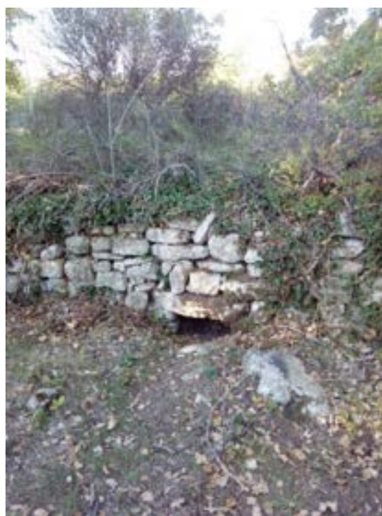
EFFONDREMENT DE LA VOUTE PEU PROFONDE DU DRAIN (PHOTO DE GAUCHE) ET DEBOUCHE DU DRAIN AU PIED DE LA MURAILLE LA PLUS EN AVAL (PHOTO MRE)
