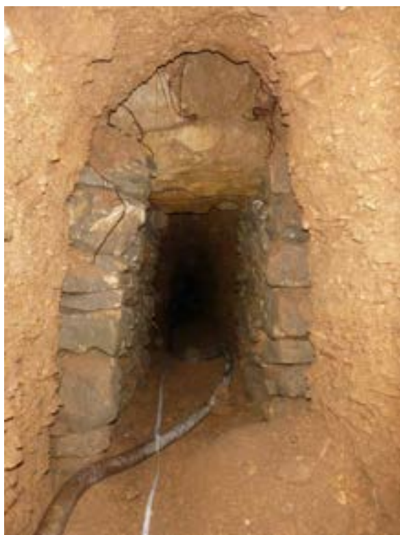
AMENAGEMENT EN PIERRES SECHES DE SOUTIEN D'UN Puits (PHOTO DE GAUCHE) ET TRONÇON DE GALERIE DANS LE SECTEUR AVAL (PHOTO DE DROITE) (PHOTO MRE)
