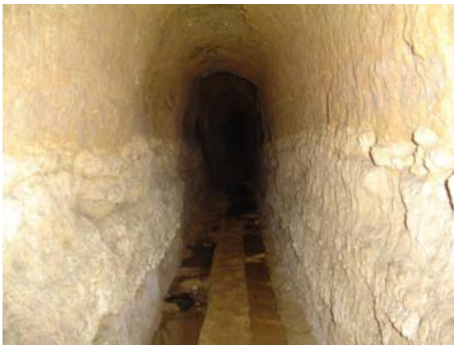
INTERIEUR DE LA LONGUE MINE DU TRANSFORMATEUR. LE CONTACT ENTRE LES DEUX COUCHES GEOLOGIQUES SONT A MI-HAUTEUR DES PAROIS (PHOTO MRE)
