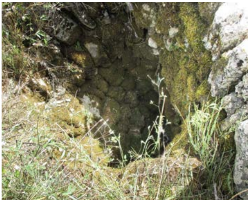
AVALOIR EN FORME D'ENTONNOIR CONTRE LA PAROI AMONT DE LA RESTANQUE LA PLUS HAUTE (PHOTO MRE)
