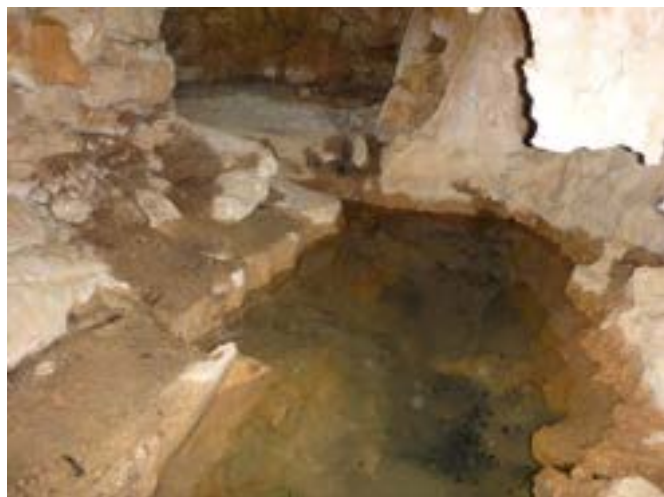
CHAMBRE DE CAPTAGE DE LA MINE AMENAGEE DANS UNE PETITE CAVITE NATURELLE DE LA ROCHE (PHOTOS MRE)
