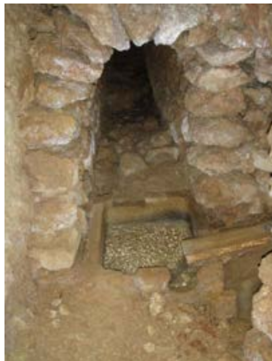
PARTIE AMONT DE L'OUVRAGE AVEC VOUTE DE PIERRES ET RIGOLE (PHOTO DE GAUCHE). INTERSECTION AVEC LE « DIVERTICULE 3 » (PHOTO DE DROITE) (PHOTO MRE)
