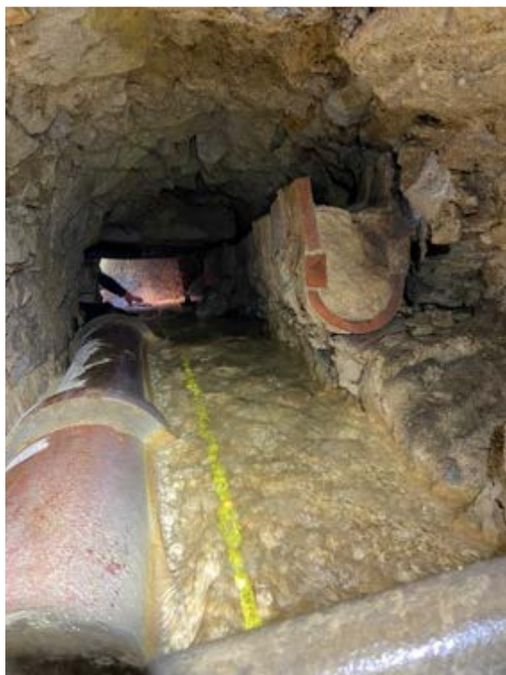
IMPORTANCE DES DEPOTS DE CALCAIRE (PHOTO SPELEH2O, 2021)
