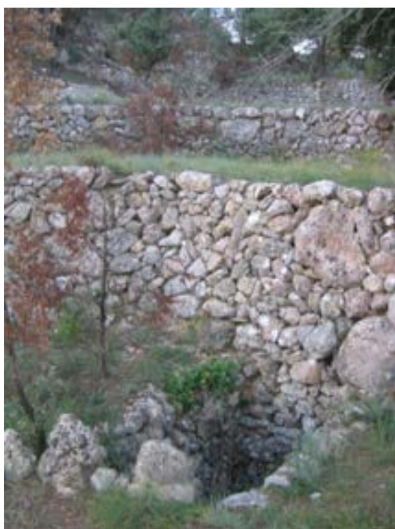
REGARD D'ACCES AU DEBOUCHE DU DRAIN AU POINT PAS DE LA MURAILLE LA PLUS EN AVAL DU COMPLEXE (PHOTO MRE)
