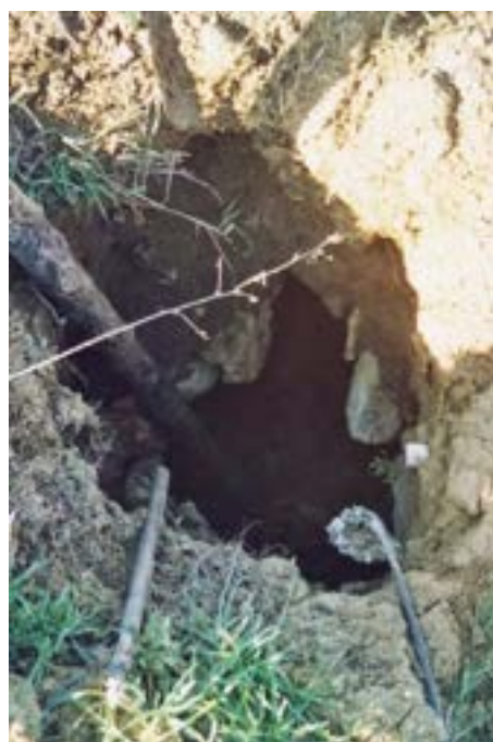
ÉBOULEMENT DE LA VOUTE DE LA GALERIE DRAINANTE A 130 METRE EN AMONT ENVIRON DE SON DEBOUCHE (PHOTO MRE)
