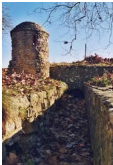
DEBOUCHE DE LA GALERIE DRAINANTE DANS UN CANAL AERIEN (PHOTO DE GAUCHE) ET CITERNE « AU FIL DE L'EAU » (PHOTO DE DROITE) (PHOTOS MRE)
