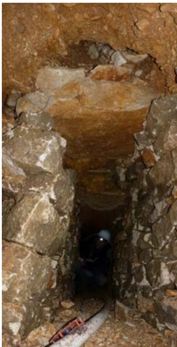
TRONÇONS DE GALERIES CREUSEES DANS LES COLLUVIONS (PHOTOS DE GAUCHE) ET SEGMENT BATI EN PIERRES SECHES RENFORÇANT LA POSITION D'UN PUIS VERTICAL (PHOTO DE DROITE) (PHOTOS MRE)
