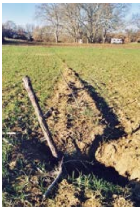
ÉBOULEMENT DE LA VOUTE DE LA GALERIE DRAINANTE A 130 METRE EN AMONT ENVIRON DE SON DEBOUCHE (PHOTO MRE)
