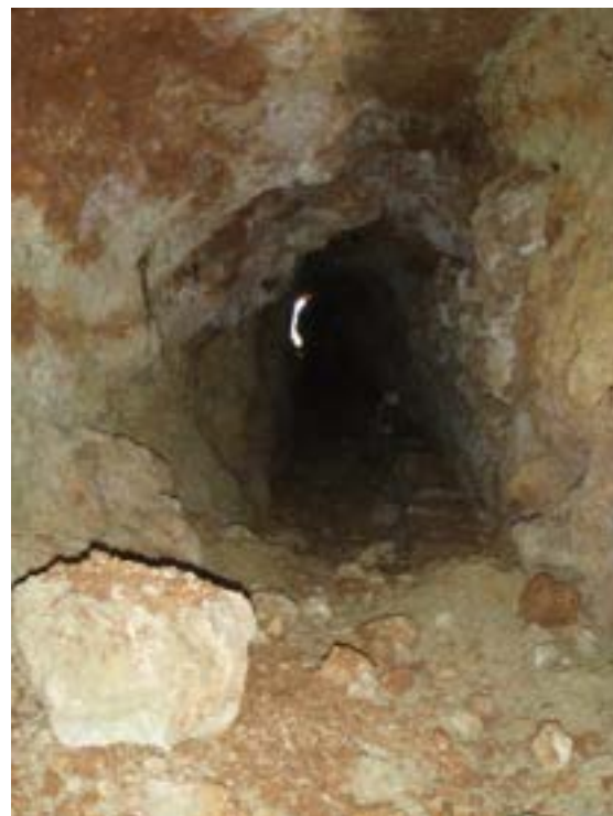
L'EAU S'ECOULE VERS L'ENTREE DE LA MINE PROTEGEE DANS LA RIGOLE. LA GEOLOGIE FRIABLE DES PARTIES NON BATIES DE LA MINE OCCASIONNE DES EBOULEMENTS (PHOTO MRE)
