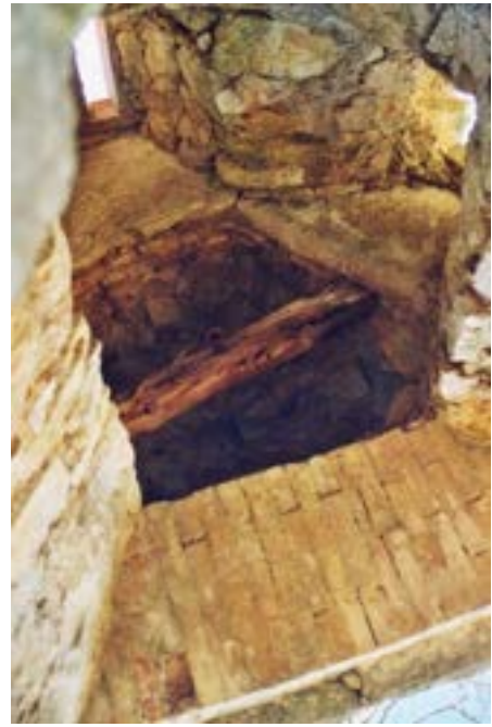
CITERNE BATIE A COTE DU DEBOUCHE DE LA GALERIE VUE DE L'EXTERIEUR (PHOTO DE GAUCHE) ET DE L'INTERIEUR (PHOTO DE DROITE) (PHOTOS MRE)
