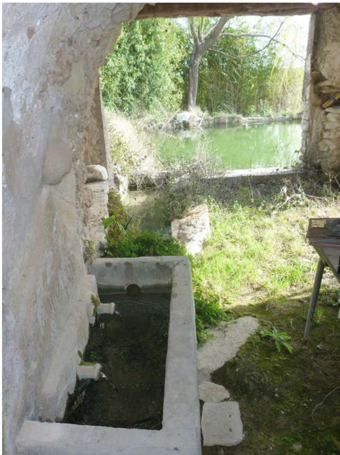
L'EAU DE LA MINE ALIMENTE SUCCESSIVEMENT LA FONTAINE, UN PETIT LAVOIR PUIS UN GRAND BASSIN AGRICOLE (PHOTO MRE)
