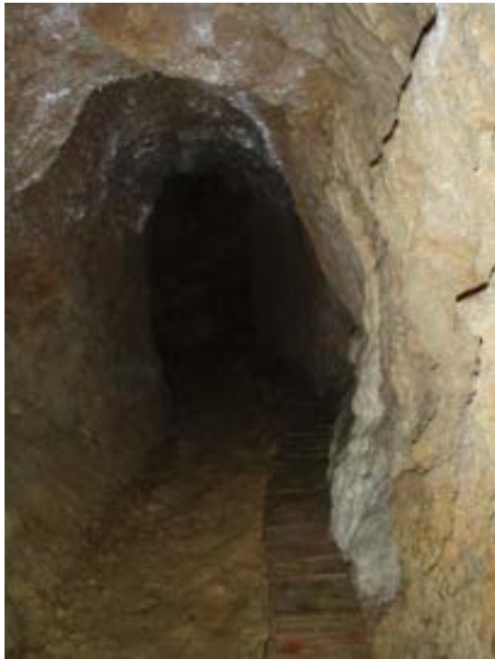
ACHEMINEMENT DE L'EAU DANS UNE RIGOLE BATIE ET COUVERTE. LA GALERIE EST SIMPLEMENT TAILLEE (PHOTO MRE)
