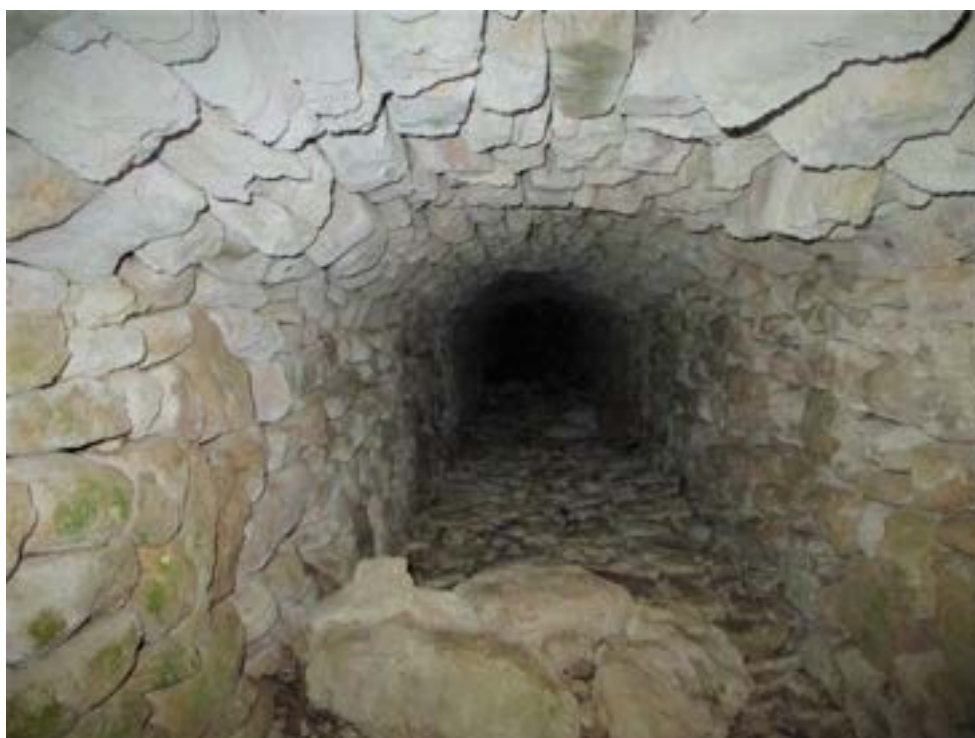
GALERIE AUX PAROIS ET A LA VOUTE EN PIERRES SECHES AVEC UN SOL CALADE (PHOTO MRE)
