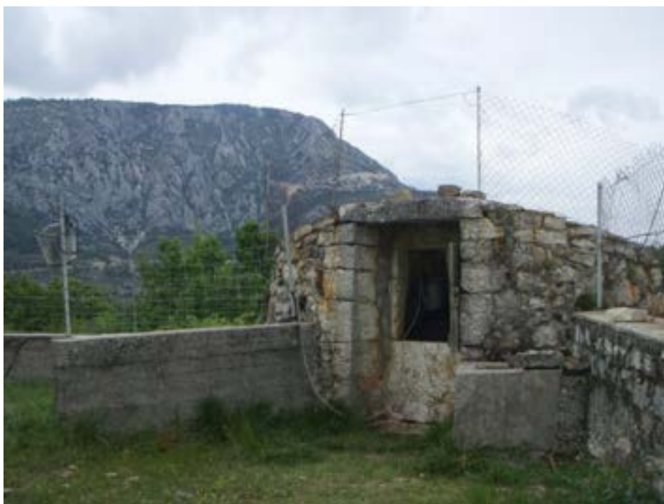
CITERNE BATIE ET FERMEE, SE REMPLISSANT AVEC LES EAUX PLUVIALES ACHEMINEES PAR LA GOUTTIERE (PHOTO MRE)
