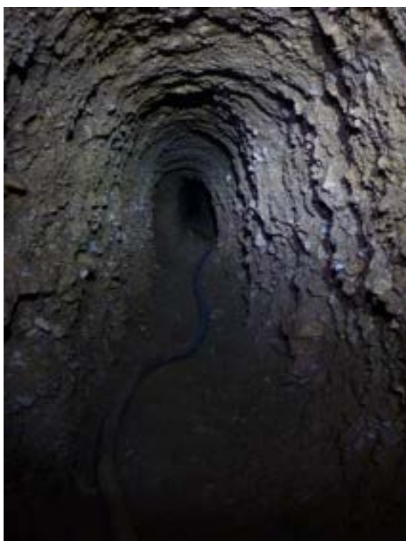
TRONÇONS DE GALERIES CREUSEES DANS LES COLLUVIONS (PHOTOS DE GAUCHE) ET SEGMENT BATI EN PIERRES SECHES RENFORÇANT LA POSITION D'UN PUIS VERTICAL (PHOTO DE DROITE) (PHOTOS MRE)
