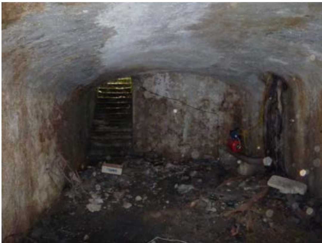
CITERNE SOUTERRAINE COLLECTANT LES EAUX DE LA MINE (PHOTO MRE)
