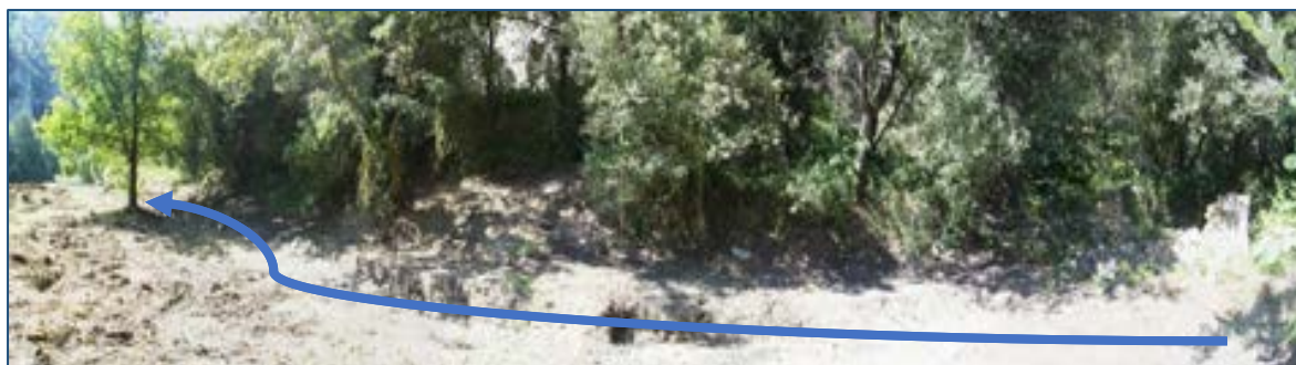
VUE D'ENSEMBLE DU DRAIN DECAISSE EN 2011. IL COLLECTE LES EAUX DU FOND DU VALLON (A DROITE SUR L'IMAGE) ET LES ACHEMINE VERS UN BASSIN (AU FOND A GAUCHE SUR L'IMAGE) (PHOTO MRE)
