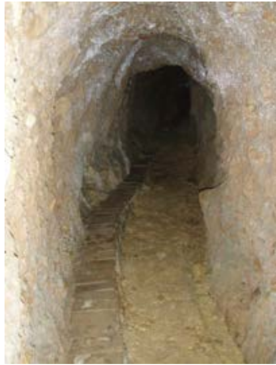
ACHEMINEMENT DE L'EAU DANS UNE RIGOLE BATIE ET COUVERTE. LA GALERIE EST SIMPLEMENT TAILLEE (PHOTO MRE)
