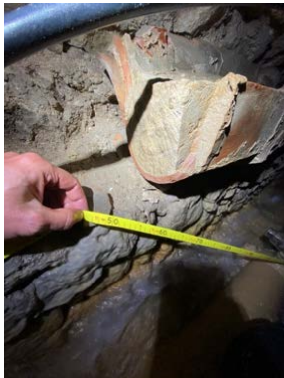
IMPORTANCE DES DEPOTS DE CALCAIRE (PHOTO SPELEH2O, 2021)
