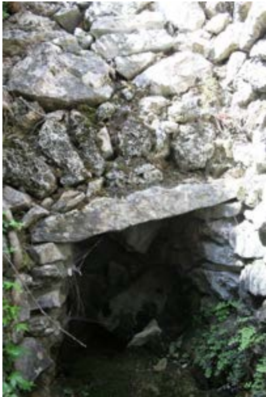
DEBOUCHE DU DRAIN AU PIED DE LA MURAILLE (PHOTO DE GAUCHE) ET DEPART DE L'EAU DANS LA GALERIE OPPOSEE (PHOTO DE DROITE) (PHOTO MRE)
