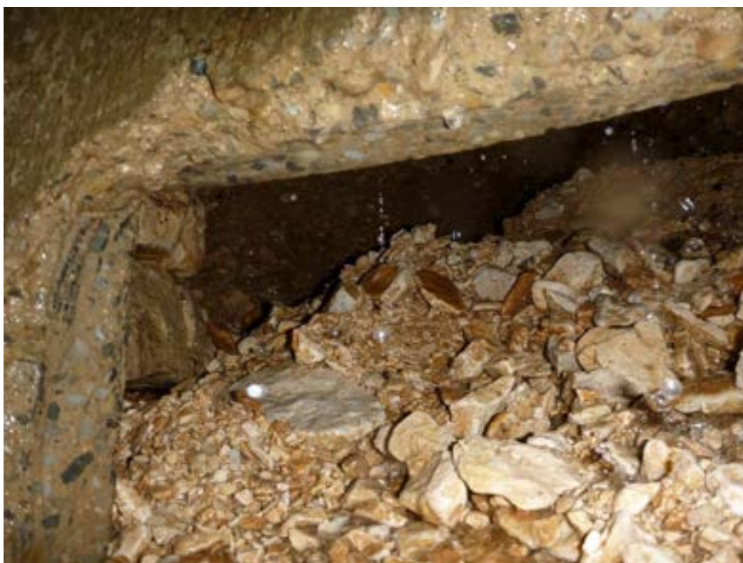
EFFONDEMENTS DE COLLUVIONS OBSTRUANT LE PASSAGE AU NIVEAU DU Puits BUSE AMONT. (PHOTO MRE)
