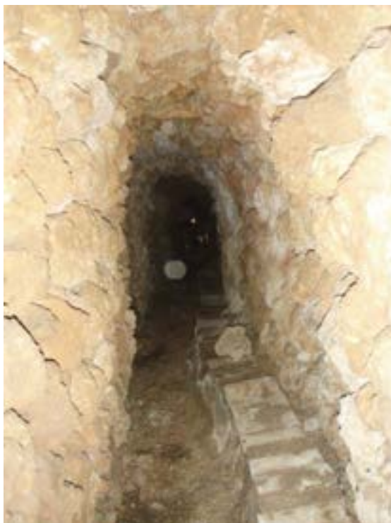
L'EAU S'ECOULE VERS L'ENTREE DE LA MINE PROTEGEE DANS LA RIGOLE. LA GEOLOGIE FRIABLE DES PARTIES NON BATIES DE LA MINE OCCASIONNE DES EBOULEMENTS (PHOTO MRE)
