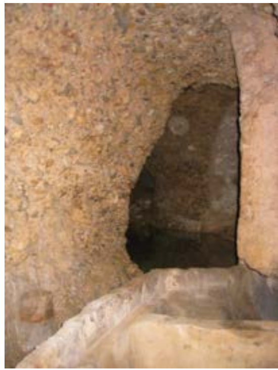
UN DIVERTICULE AU FOND DE LA MINE CAPTE UNE « VEINE D'EAU » (PHOTO DE GAUCHE). CELLE-CI S'ACCUMULE ET MET EN CHARGE UNE RIGOLE (PHOTO DE DROITE) (PHOTO MRE)
