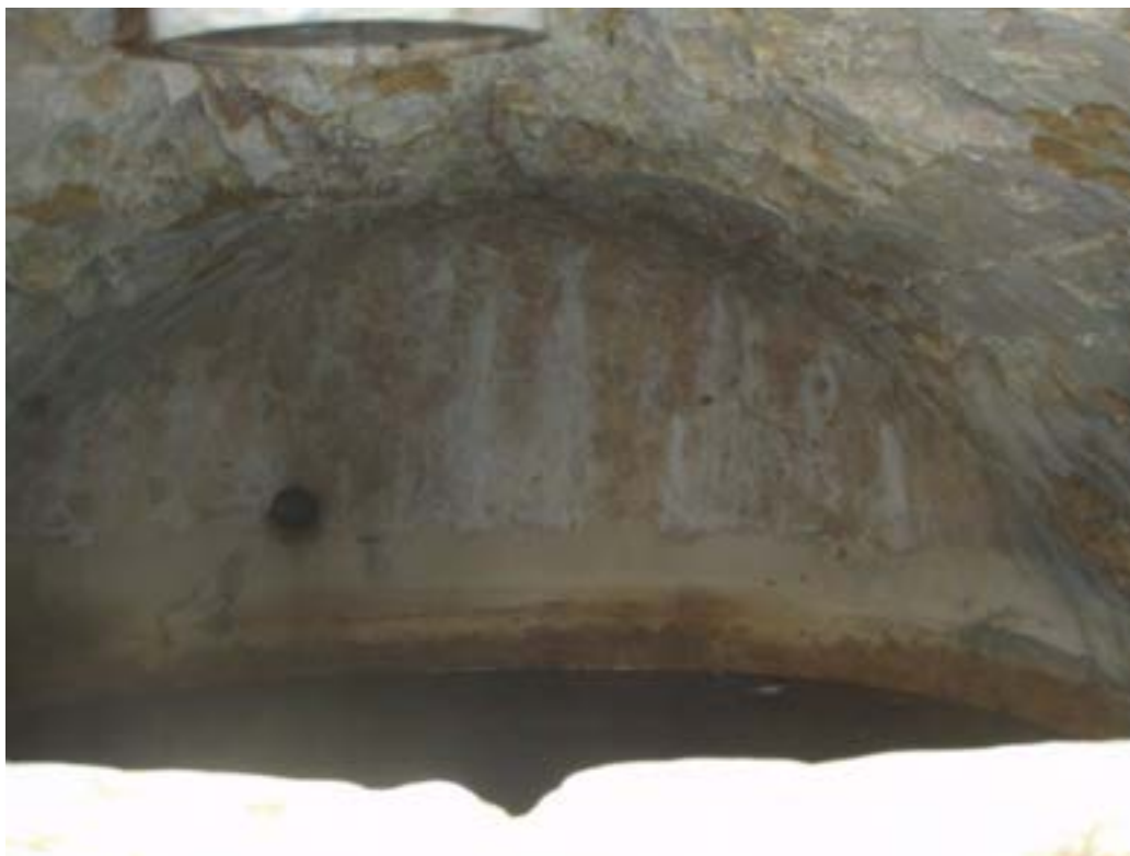
L'ÉTANCHEITE DE LA CITERNE EST ASSURÉE PAR UN ENDUIT LISSE (PHOTO MRE)
