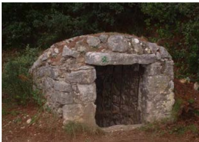
DEBOUCHE DE LA GALERIE DRAINANTE DANS UN CANAL AERIEN (PHOTO DE GAUCHE) ET CITERNE « AU FIL DE L'EAU » (PHOTO CI-DESSOUS) (PHOTOS MRE)
