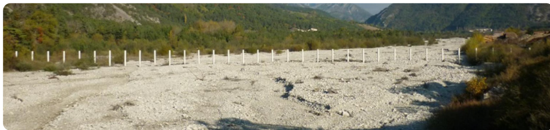
• Râtelier à flottants situés sur la Béoux, affluent du Petit Buëch (Hautes-Alpes)
