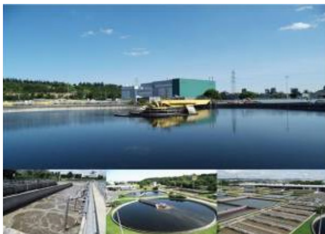
Station d'épuration de Saint-Fons Source : Saur
