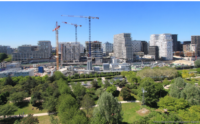
État d’avancement de la construction de l’éco-quartier de Clichy-Batignolles Source : Paris & Métropole Aménagement
