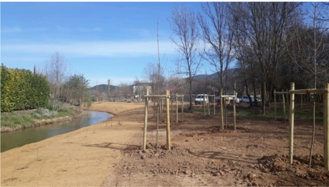
Plantations en cours sur l’aval du projet, après abaissement de la rive gauche Source : SMBVH
