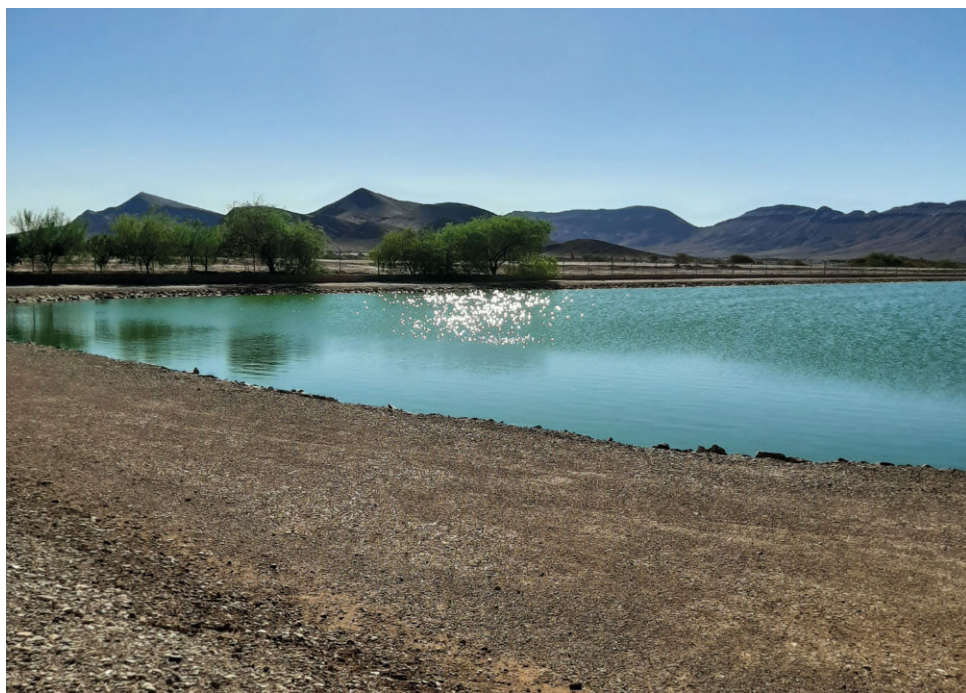
Station d'épuration de Tata, © pS-Eau, septembre 2024
