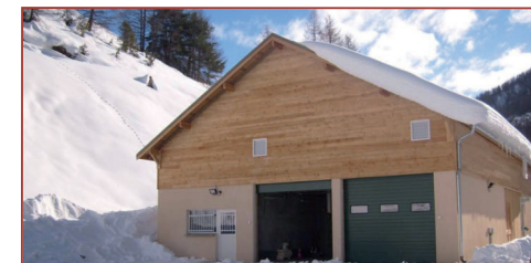
> Station d'épuration de Moline, mise en service en 2008 (source : Communauté de Commune Escarton du Queyras)
