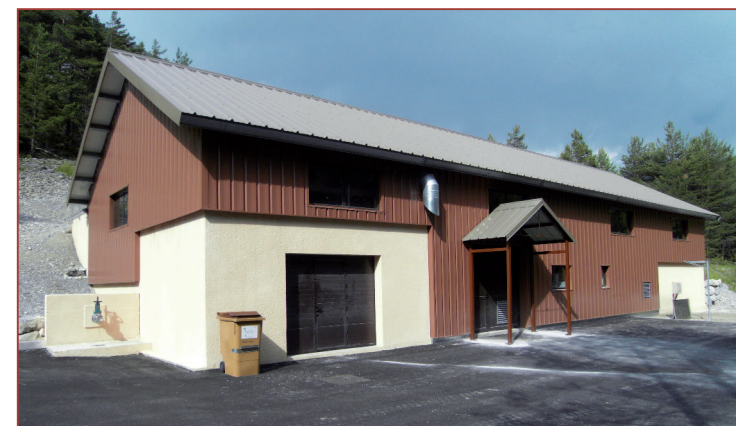
> Station d'épuration de Ceillac, mise en service en 2008 (source : Communauté de Commune Escarton du Queyras)
