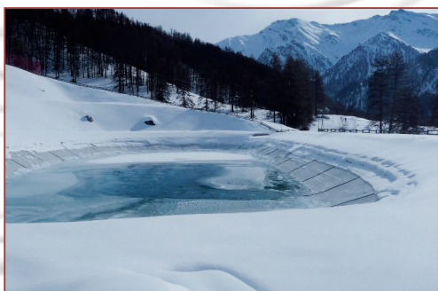
> Retenue collinaire (source : Catherine Sénéchal - PNRQ)
