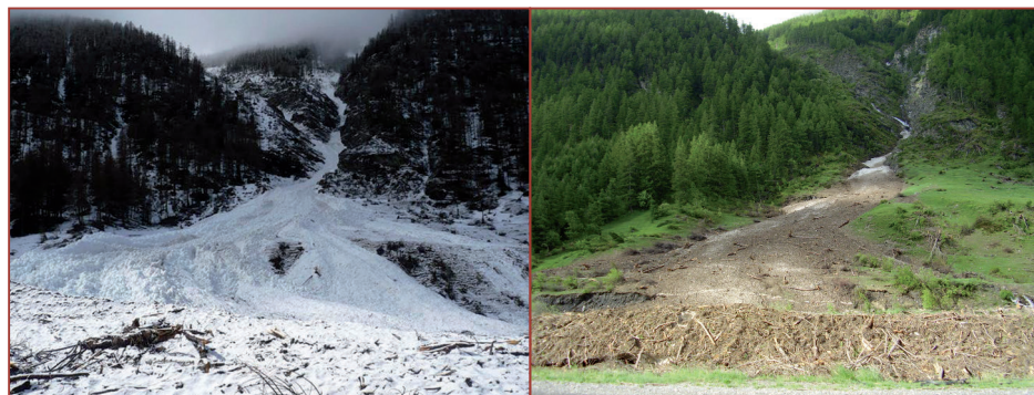
> Avalanche de la Fourche entre Ristolas et l'Echalp en avril 2009 (source : Le Dauphiné)
