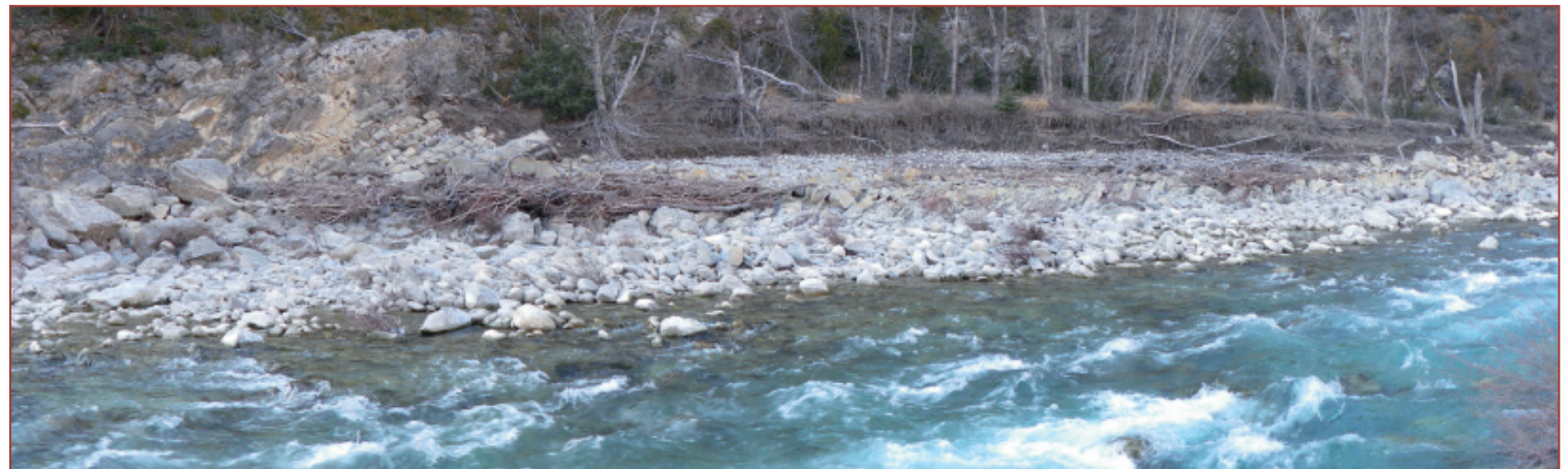
> Enfoncement du lit (source : MRE) |
