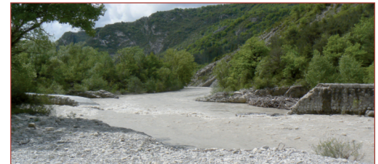
> Barrage cassé des Chambons après travaux (source : SMIGIBA) |
