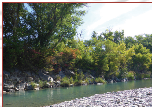
> Enrochement du Buëch à Laragne (source : MRE) |
