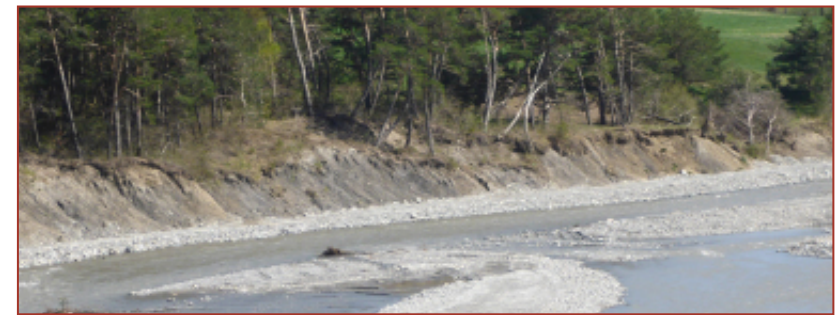
> Enfoncement lit du drac (Source: MRE)
