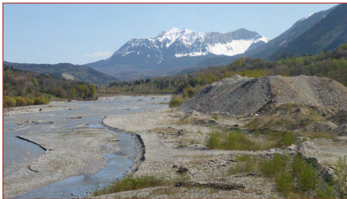
> Matériaux pour la recharge sédimentaire du lit du Drac (Source : MRE) |
