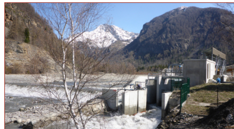
> Prise d'eau du canal de Gap (Source: MRE) |
