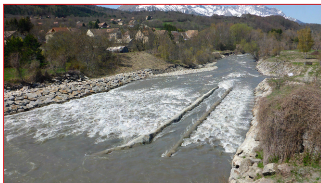
> Travaux de restauration sur le Drac (Source: MRE)
