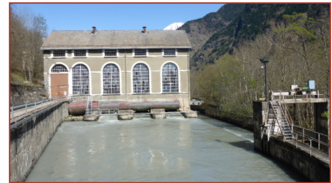
> Usine hydroélectrique de Saint-Maurive sur la Séveraisse (Source: MRE)
