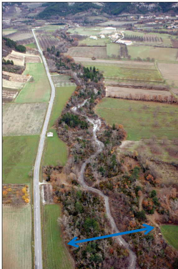
Figure 51 : sur le torrent de la Béoux (26), l'ancien lit en tresses (flèche bleue) est devenu corridor forestier sous l'effet du tarissement des apports sédimentaires (© Rodolphe Montagnon)
