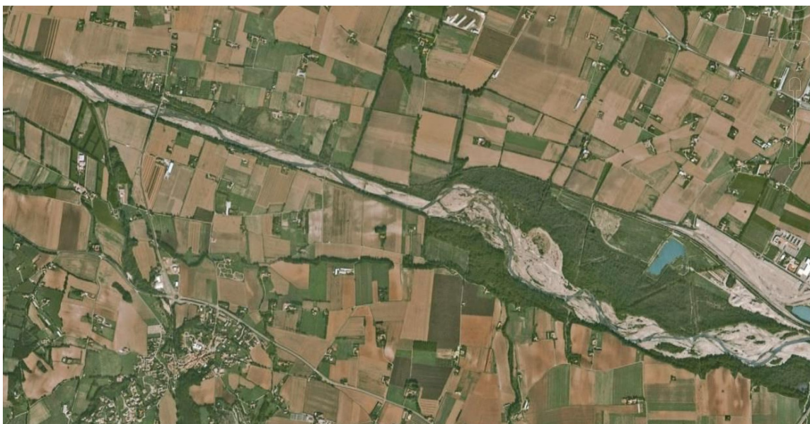
Figure 87 : effet d'un endiguement resserré sur un tronçon en tresses, rivière Drôme (source : GoogleEarth)
