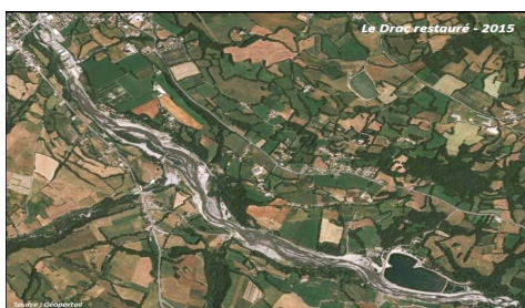
Figure 58 : vue aérienne du Drac en 2015 après les travaux de reconstitution du matelas alluvial ; source des photographies : ©CLEDA, Burgeap et IGN
