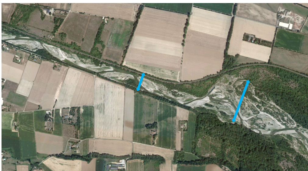
Figure 18 : réduction brutale de la largeur de bande active de tressage d'environ 300 m à 110 m par endiguement à Allex (26) (© Google earth)
